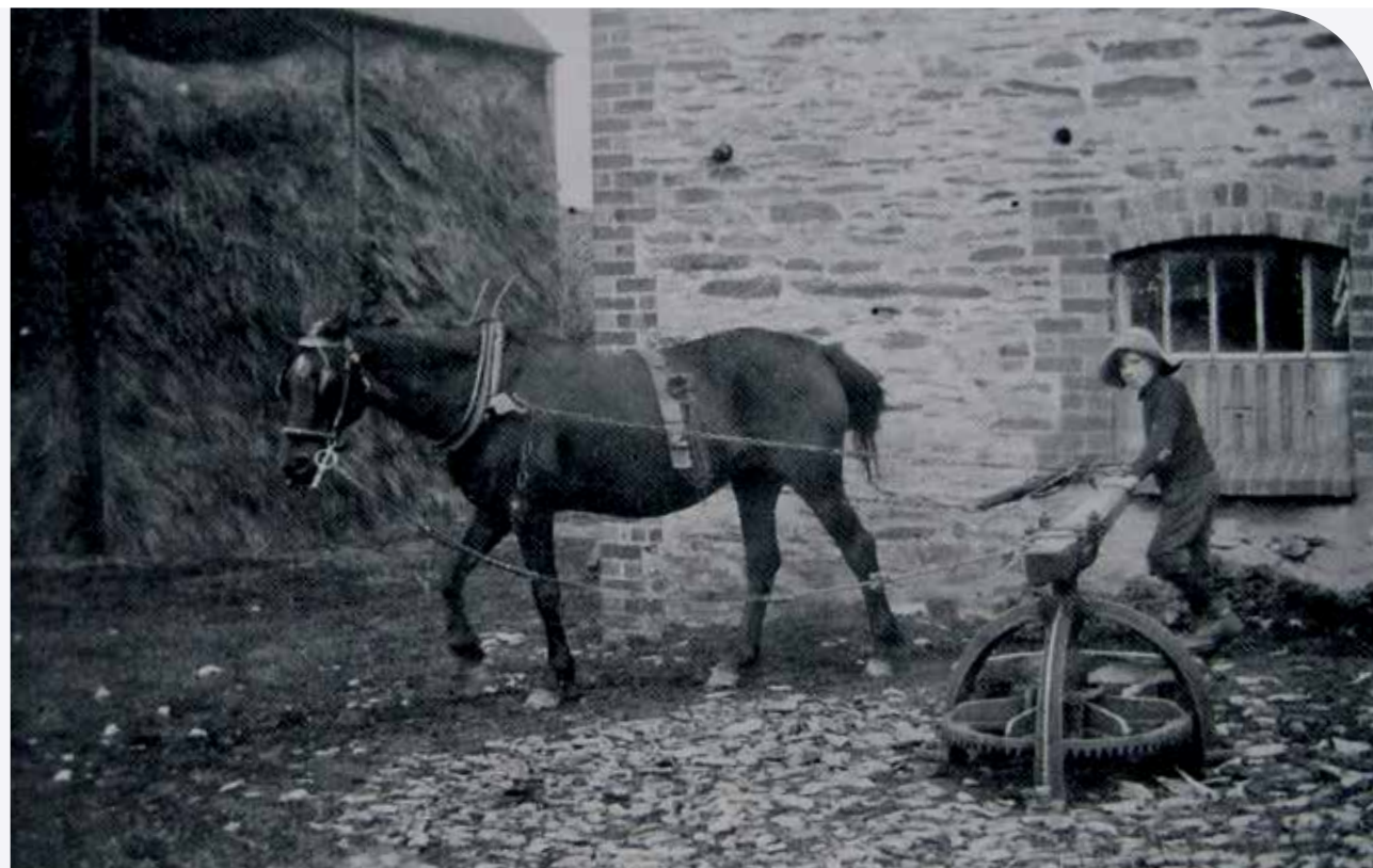
Hier zien we een rosmolen in werking. Daarbij paardenkracht wordt omgezet in een roterende beweging om werktuigen of machines aan te drijven.
