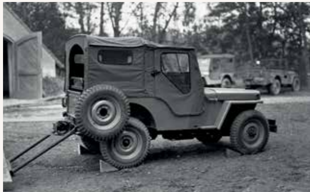
Voor het werken met de poelie wordt de Jeep met blokken 'vastgezet'.
